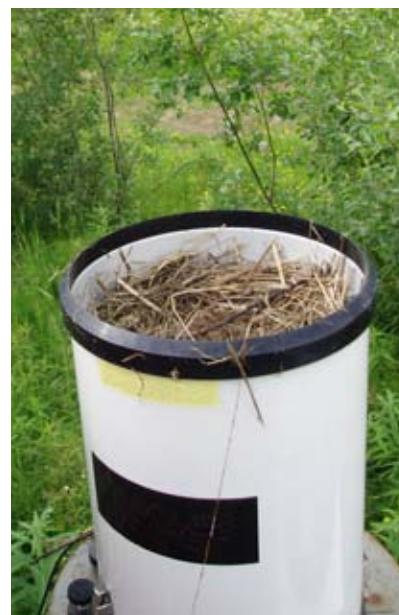
Figur 2-3 Nederbördsgivare med driftproblem. Foto: Rune Skog, Tromsø kommune.
