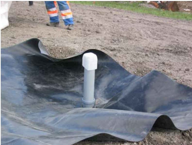
Figur 1-4 Installation av lysimeter på SRV:s provyta, Sofielund.
