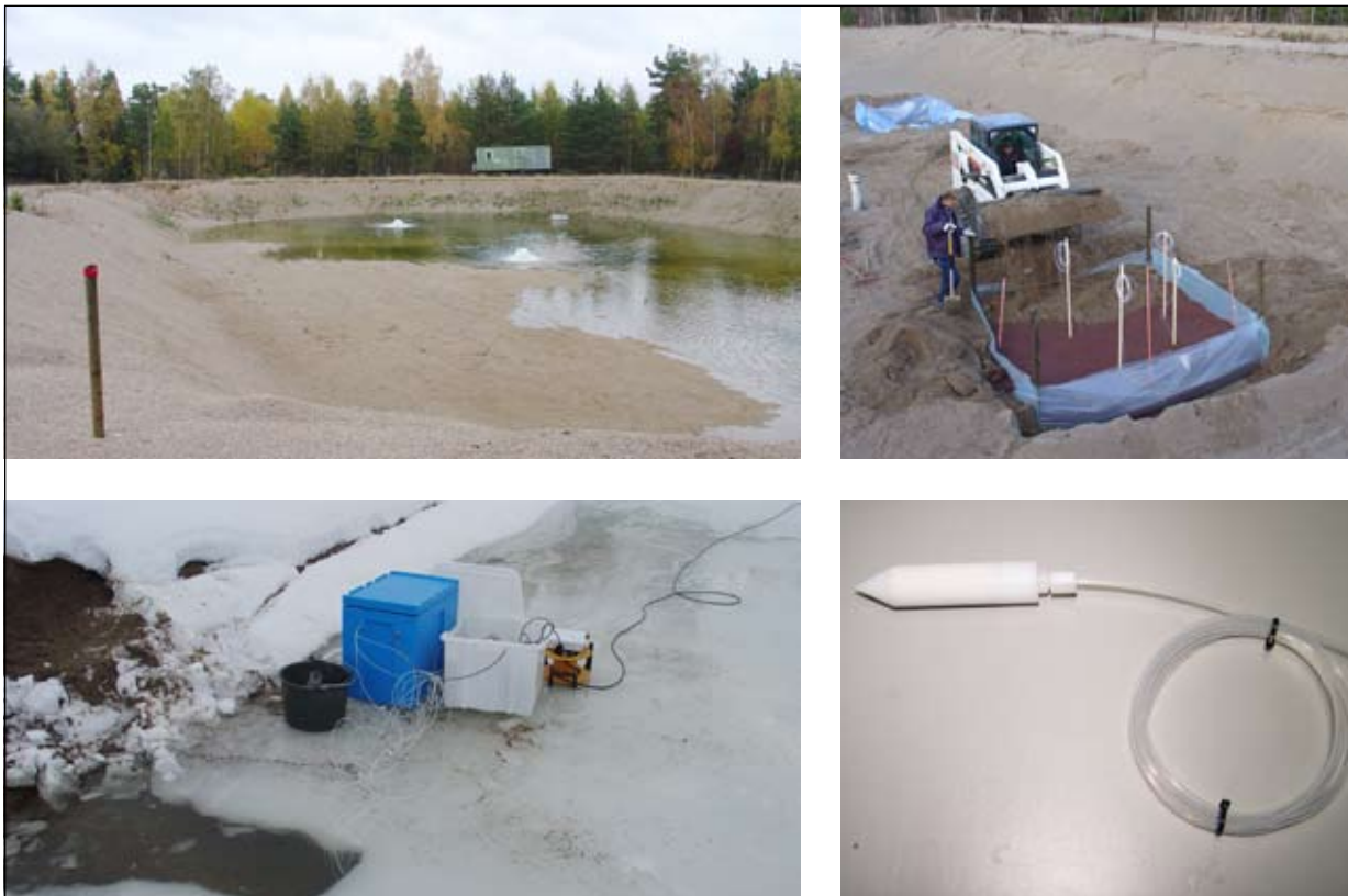
Figur 4 Infiltrationsbassängen vid Hyndevads vattenverk där försöksytorna med IOCO-materialet anläggs, anläggandet av försöksytorna, och vattenprovtagning i december 2004 när bassängen var istäckt. Bilden längst ner till höger visar en Prenartspets.
