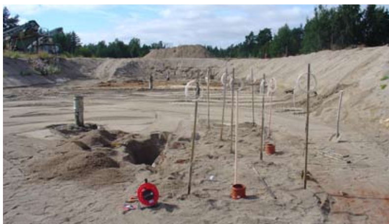
Figur 6 In situ-permeametrarna med muffarna som sticker upp ovanför bassängbotten. Bilden visar Försöksyta 2. Den borte permeameteren sitter i försöksytan och den närmaste strax utanför.
