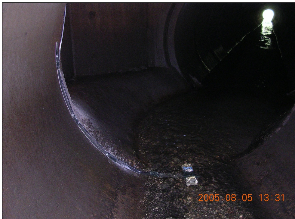
Figur 2–2. Bilden visar en v/h-mätare installerad i vattengång i en Ø1600 mm dagvattenkylvert
