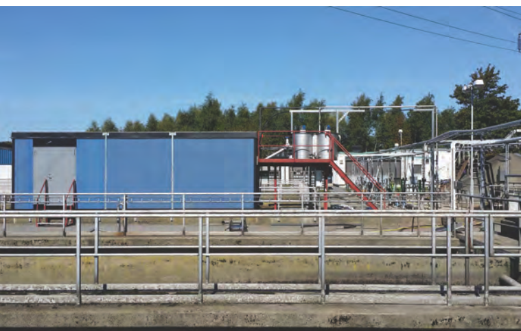
Pilotanläggningen på Källby avloppsreningsverk är baserad på komplett rening av kommunalt avloppsvatten med enbart filtrering utan biologi.
