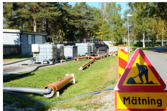
Figur 13. Provuppställning för utvärdering av svackdike med styrda tillflöden samt mätutrustning för flöde och markfuktighet. Bergnäset, Luleå.
