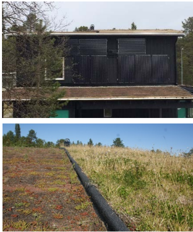
Figur 9. Sjunde huset i Kiruna. Den övre bilden visar hur huset och takdelarna är belägna (taket över carporten ingår ej i projektet). Nedre bilden visar skillnaden i växtlighet på de olika takdelarna.
