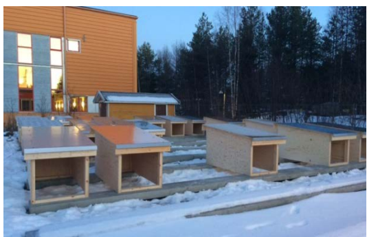
Figur 7. Pilotytor med olika byggnadsmaterial har under 2016 uppförts vid LTU-campus.
