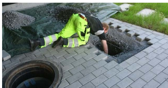
Figur 18. Montering av temperaturgivare. Kiruna, juli 2016.
