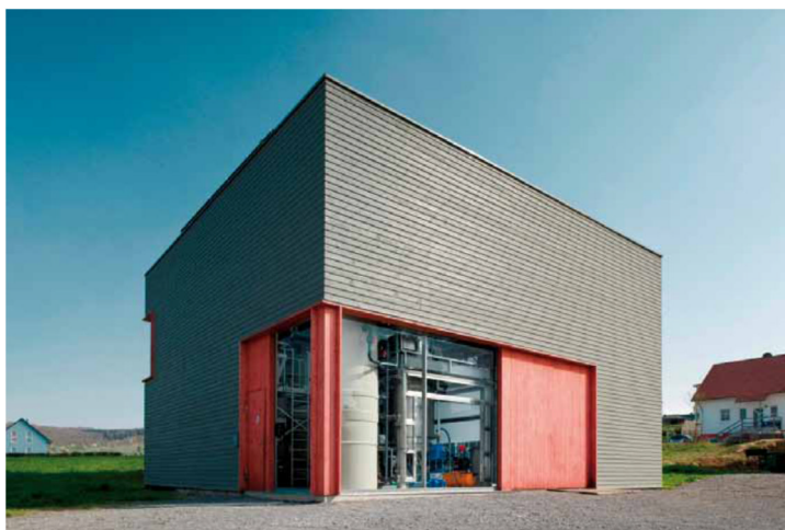
Figur 7 - Foto över den lokala behandlingsanläggningen "Das Wasserhaus". Foto med tillstånd av Fraunhofer Institut, Stuttgart.
