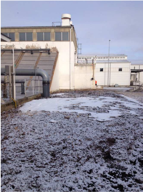
Figur 3-3. Barkfilter en kall vinterdag
