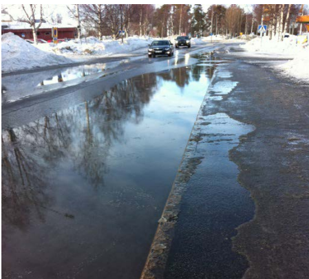
Figur 8. Tidig snösmältning på villagata av normalutförande. Notera omfattande ytlig vattenbildning!
