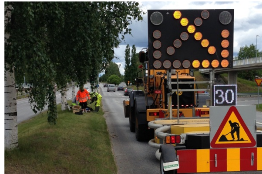
Figur 8. Installation av utrustning i Umeå
