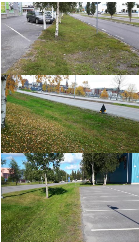
Figur 8: Två beväxta svackdiken i centrala Luleå samt (längst ned) vid LTU campus.
