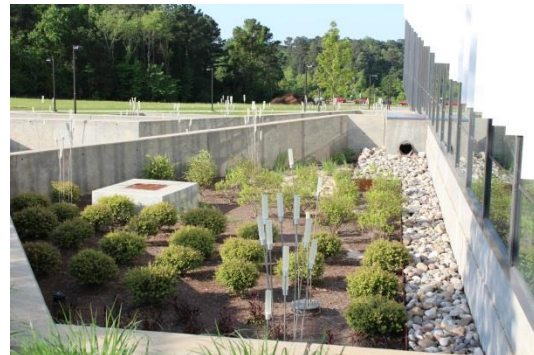
Figur 5. Dagvattenbiofilter, North Carolina, USA.
