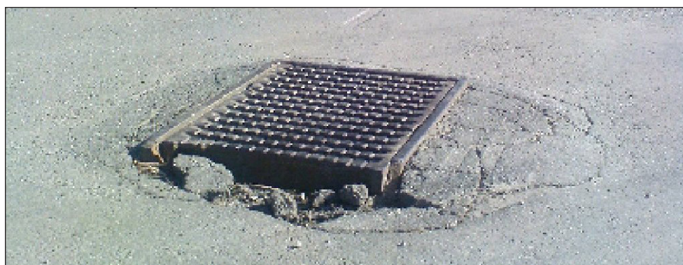
Figur 3-2. Tjälskadad regnvattenbrunn.
