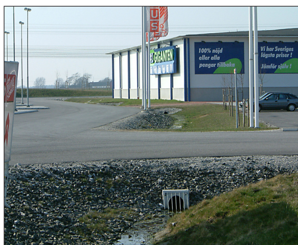
Figur 5-5. Från asfaltytorna avrinner vattnet till fördröjningsdiken och dammar.
