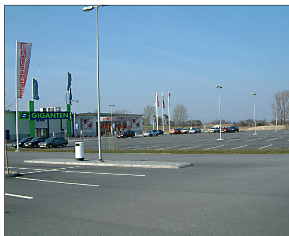
Figur 5-4 Stor sammanhängande asfaltyta, dock utan rännstensbrunnar.
