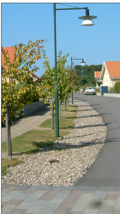
Figur 5-9, 5-10 och 5-11. Förebyggande åtgärder! Känns avsevärt bättre! Dränerande makadamstråk, urschaktade svackdiken och urschaktade fördröjningsdammar med flödesreglering. Mariastaden, Helsingborg.
