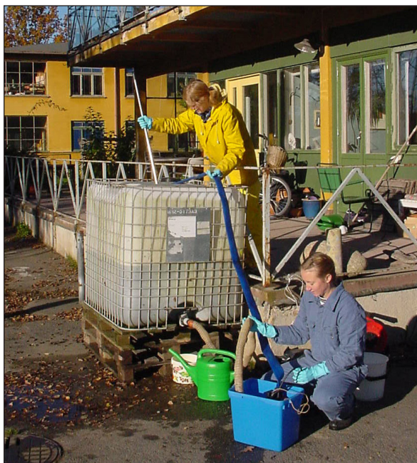
Figur 3-6. Uppsamlingsstankens insidor skrapas med gummiskrapa och urinblandningen omblandas med hjälp av en pump (Foto: Å. Andersson).
