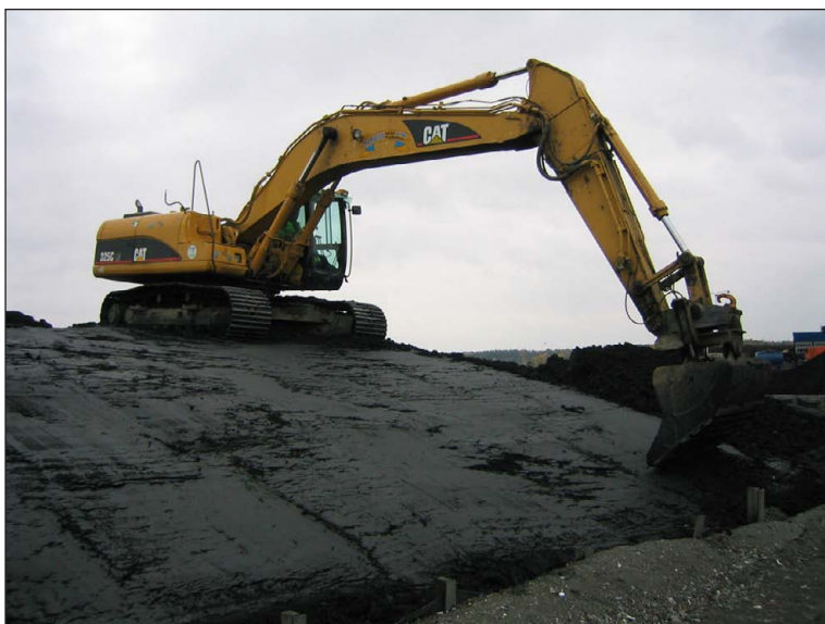
Figur C1-3. Packning med skopa i slänt.
