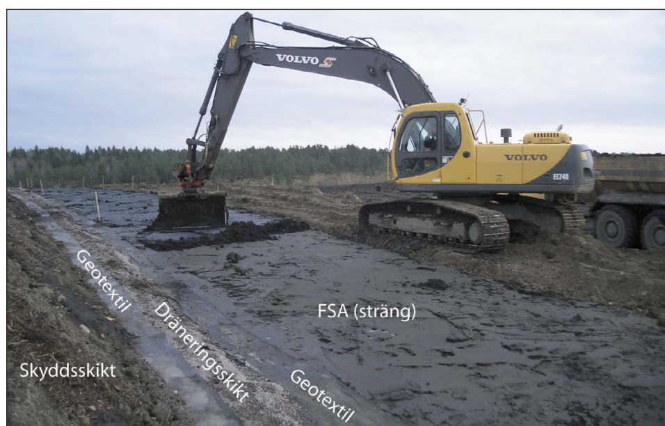
Figur C4-2. Exempel: Utlagt FSA-skikt, dränerings- och skyddslagret, Lilla Nyby, Eskilstuna.
