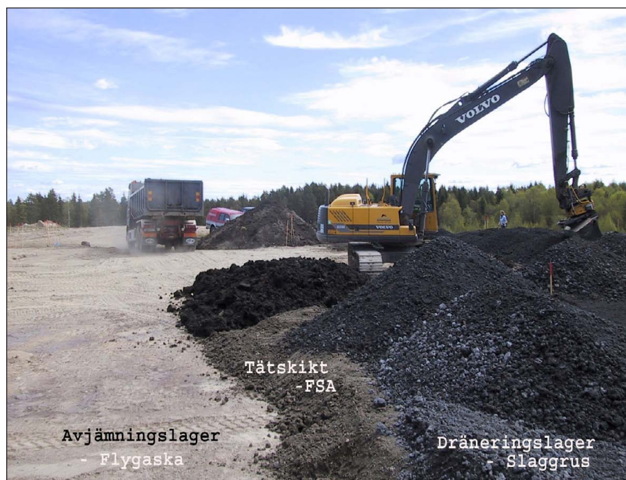
Figur C3-2. Exempel: Utlagt avjämningskikt, FSA-, dränerings- och skyddslager, Dragmossen, Älvkarleby.
