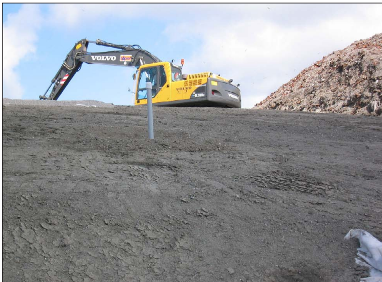
Figur C2-3. Utläggning av FSA-blandning.
