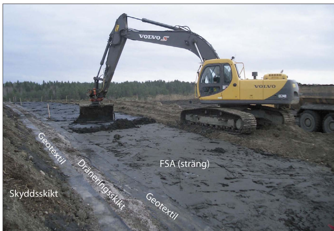
Figur 4-2. Exempel: Utlagt FSA-, dränerings- och skyddsskikt, Lilla Nyby, Eskilstuna.
