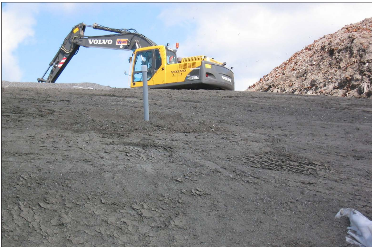
Figur 4-3. Packning av utlagt FSA med bandgående fordon, SRV återvinning.
