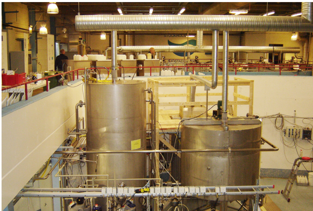
Figur 5-7 Nitrifikationstank och denitrifikationstank.
