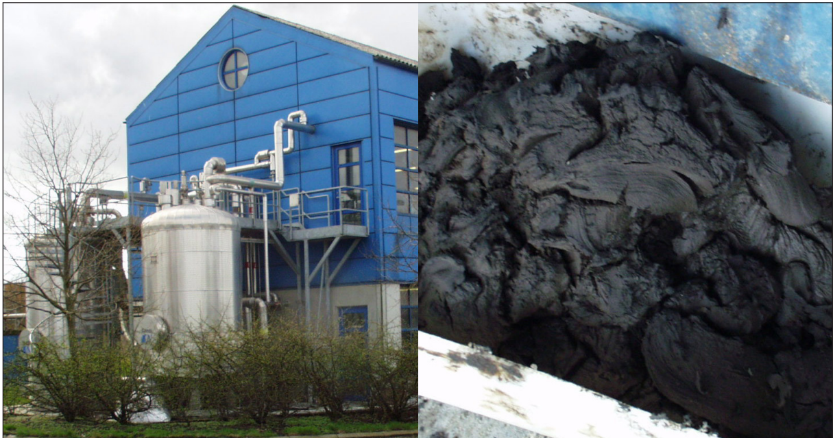
Figur 4-2. Till vänster: Cambianläggningen på Næstveds rensningsverk, Danmark. Till höger: avvattnat rötslam med torrsubstanshalt ~30 %.
