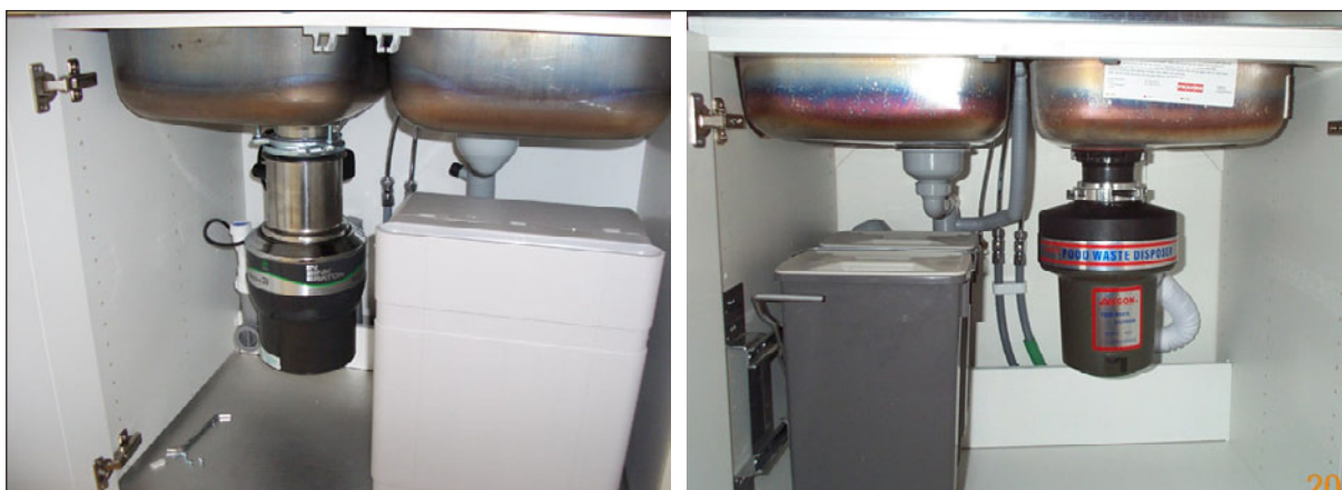
Figur 5.2 Kvarnmodellerna Disperator 178 (till vänster) och Jegon 400 (till höger) på plats i Skogaberg.
