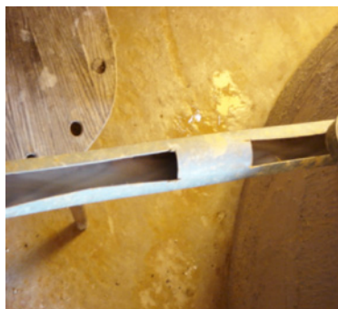
Figur 3-4 Transport av AVR-lösning till brunn vid fällningsdammen i Hede där blandning sker med avloppsvattnet som passerat försedimenteringsdammar. En detalj av transportledningen, som gjorts åtkomlig för rengöring, visas också.
