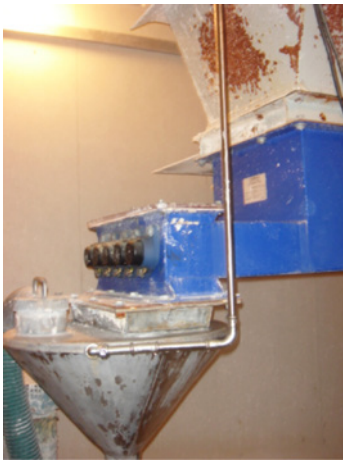
Figur 3-3 Kalkvattenberedning och inblandningspunkt i Bredbyns fällningsdamm, Örnsköldsvik.
