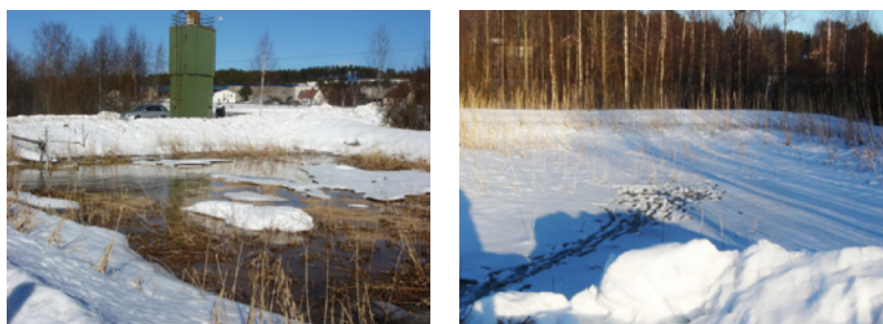
Figur 7-4 Fällningsdamm i Långviksmon. Vänstra bilden: första dammen. Högra bilden: fjärde dammen.
