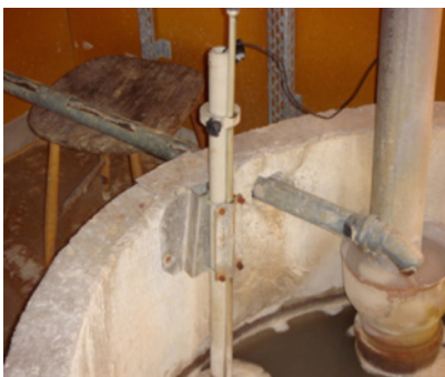
Figur 3-4 Transport av AVR-lösning till brunn vid fällningsdammen i Hede där blandning sker med avloppsvattnet som passerat försedimenteringsdammar. En detalj av transportledningen, som gjorts åtkomlig för rengöring, visas också.
