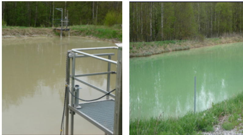
Figur 5-8 Fällningsdammen i Glössbo. Till vänster damm 1 med omrörare under respektive brygga. Till höger damm 2 med lugna strömningsförhållanden.
