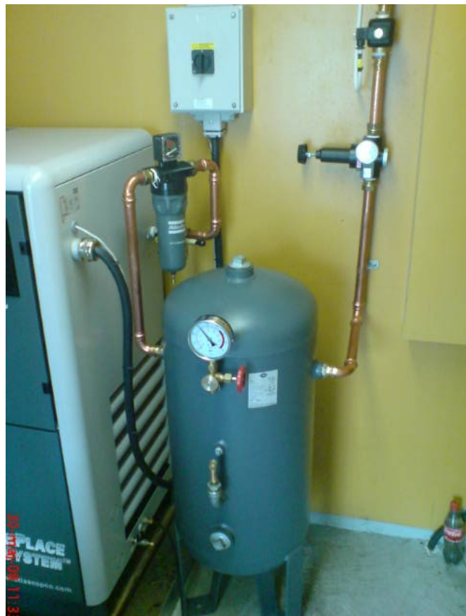
Figur 24 Installation av lufttank
