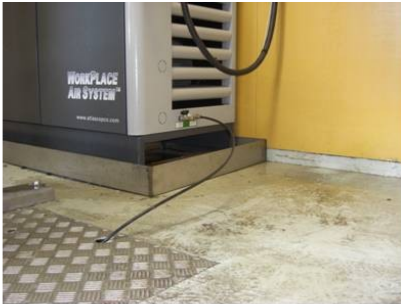
Figur 10 Bilden visar kondensavtappning
