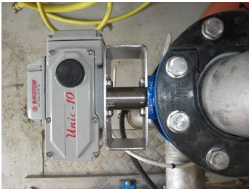
Figur 20 Ventildon med adapter
