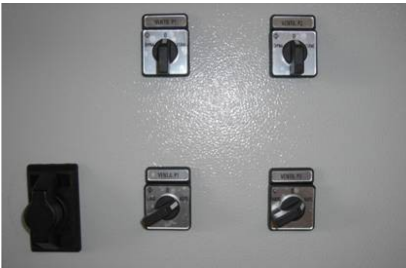
Figur 22 Manöverskåp för avstängningsventiler
