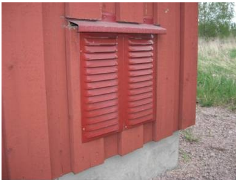
Figur 11 Tilluftsdonet, sett utifrån
