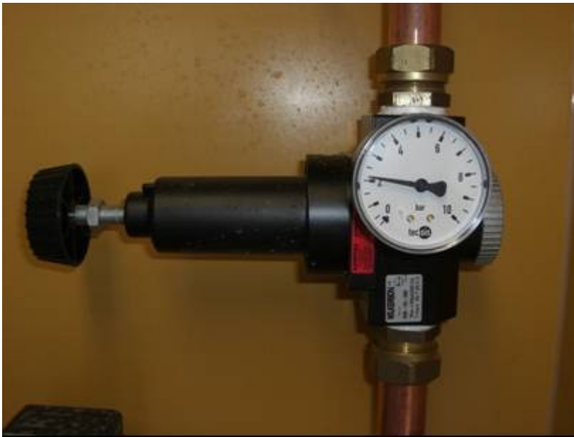
Figur 6 För att inte skada ledningen valde vi att inte använda ett högre lufttryck än vad pumparna ger dvs. ca 2,5 bar
