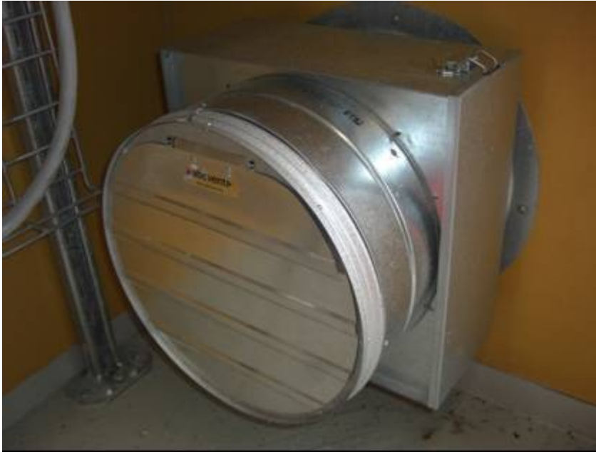
Figur 12 Tilluftsdonet, sett innifrån
