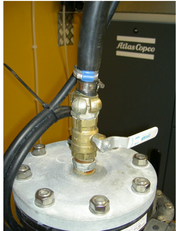
Figur 9 Anslutning mot blindfläns
