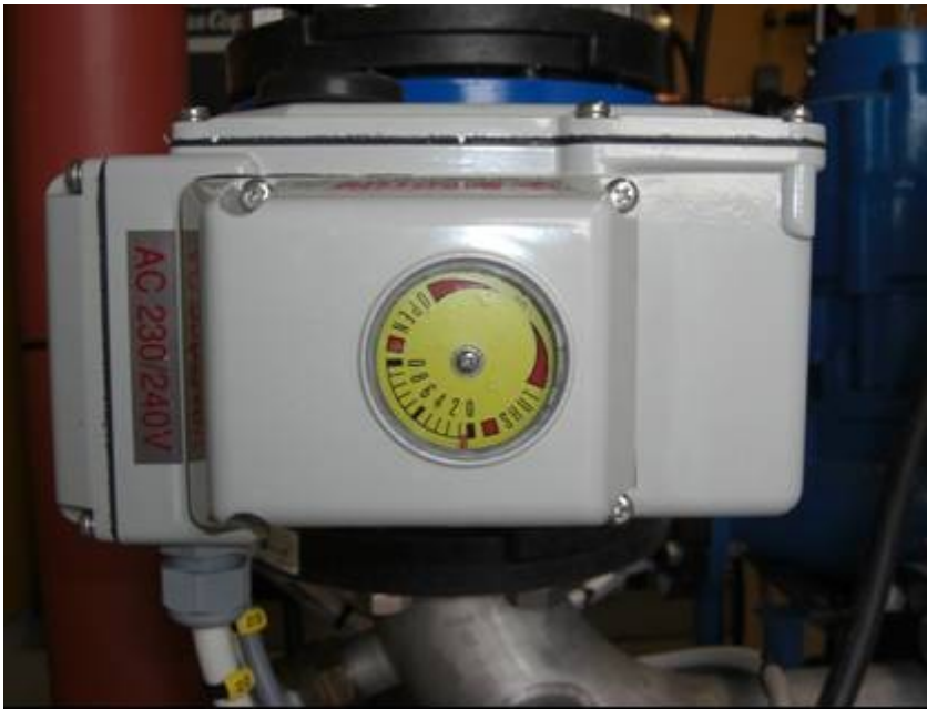
Figur 21 I det runda visarglasat finns det en mekanisk visualisering om ventilen är öppen eller stängd
