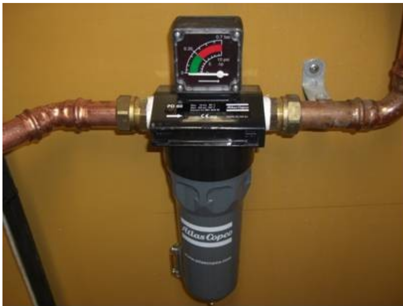
Figur 5 Bilden visar filtret som används för att filtrera bort oljan som finns i tryckluften
