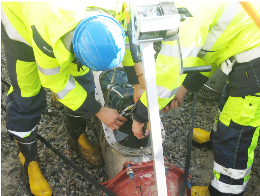
Figur 3-4 Rörscannern snart på plats i ledningen (foto: Annika Malm).
