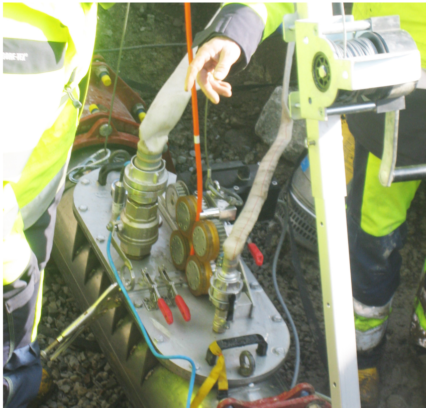
Figur 4-2 Scannern på plats i ledningen och locket påsatt (foto: Annika Malm).
