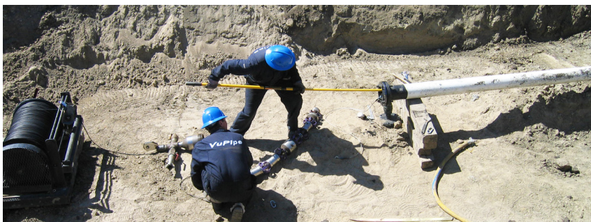
Figur 3-7 See Snake precis före insättning i röret (Bild med tillstånd från Russelltech).
