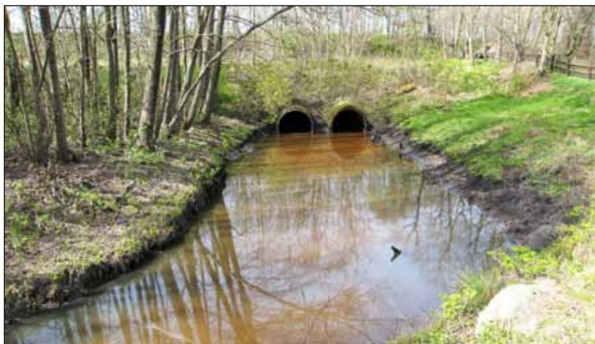
Figur B2-6 Inloppskanaler till dagvattendammen. Foto: L. Ohlsson.
