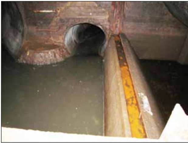
Figur 6-3 Bräddvattenpumpstation BB 17 vid torrvädertillrinning (vänster) och bräddning till Nissan vid kraftigt regn (höger), (Foto: L. Ohlsson).
