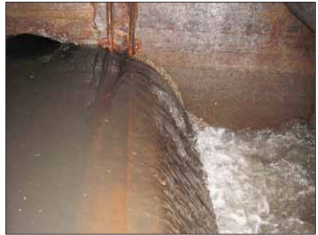
Figur 6-3 Bräddvattenpumpstation BB 17 vid torrvädertillrinning (vänster) och bräddning till Nissan vid kraftigt regn (höger), (Foto: L. Ohlsson).
