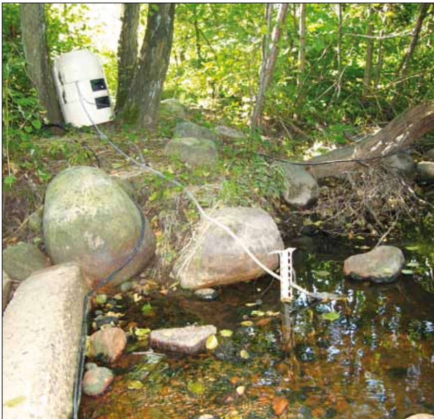
Figur B2-8 Plats för mät- och provtagningsutrustning. Foto: L. Ohlsson.
