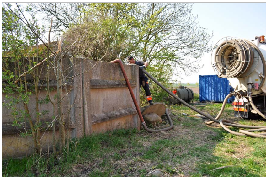
Figur 2-6 Blandning av samlingsprovet via rundpumpning med slambilen.
