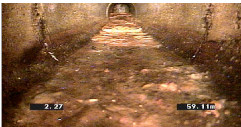
Figur 5-1 Sediment, finmaterial av grad 3 dokumenterat på en ledning som var funktionsklassad som "A". Ledningen är av betong med en dimension av 225 mm.
