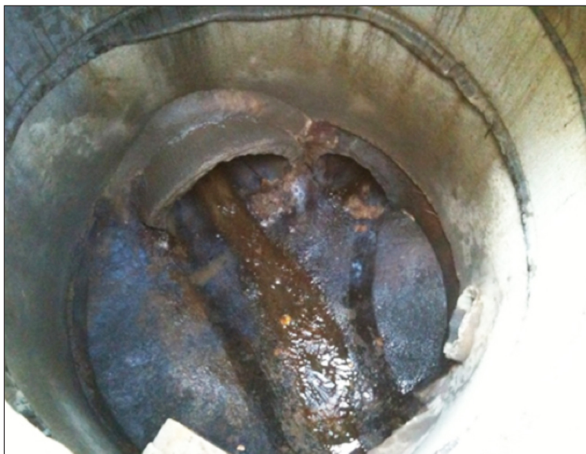
Figur 5.2 Bräddledning 300 mm från 500 mm spillvattenledning till 500 mm dagvattenledning. Vid ett regn med återkomsttiden 10 år tillförs spillvattenledningen som mest 140 l/s. Bräddning från spillvattenledning till dagvattenledning sker inte.
