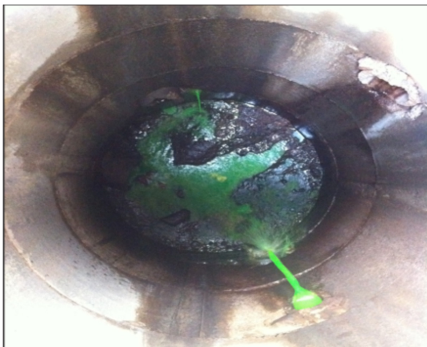
Figur 7.5 Vatten färgat med Fluoresceinnatrium i nedstigningsbrunn.
