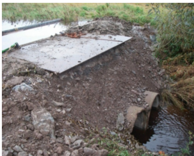
Figur 7.8 Exempel på dämning av en bäck.
