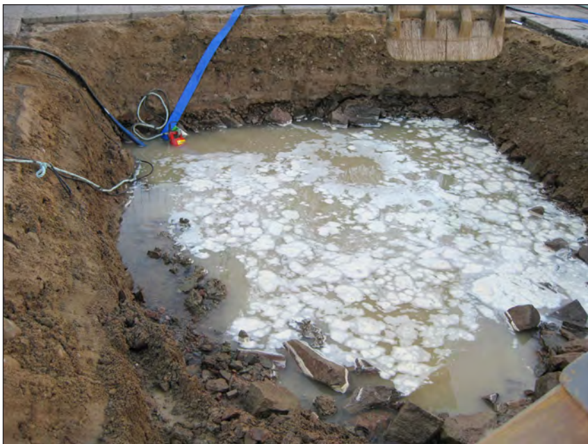
Figur 4-2 Reparation av läcka vid Centralplan i Skärblacka, april 2009
