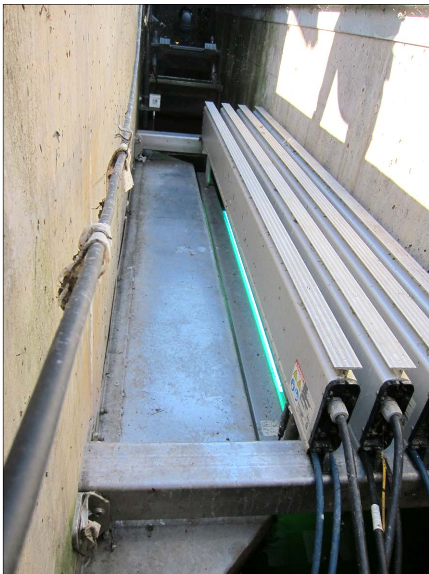
Figur 6-3 UV-ljusanläggning Arvika avloppsreningsverk.
