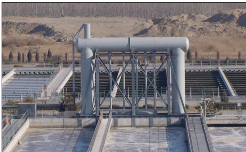
Figur 1-2 En bild av ett avloppsreningsverk i Kina med avgasningstorn.
