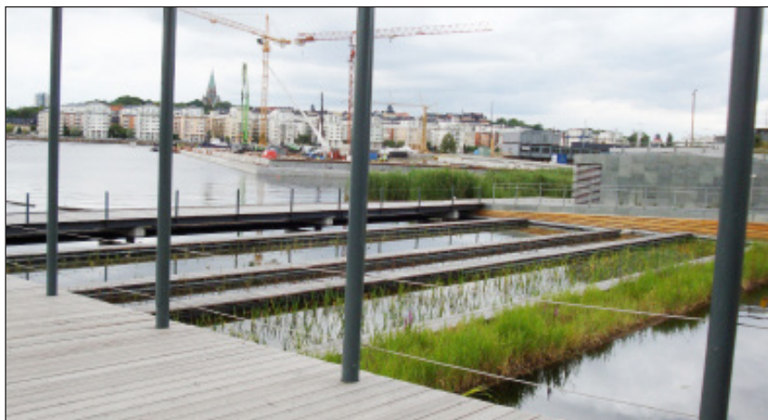
Figur 3-1 Exempel på reningsanläggning.
