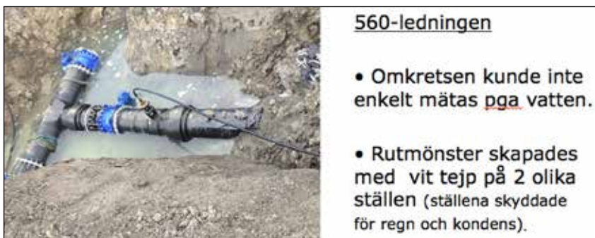
Figur 3.3.2 Bild visande gropen där svällningsmätningarna skulle göras i samband med provtryckningen av DN560-ledningen.
