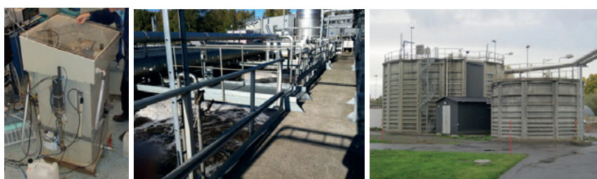
Figur 3.1 De tre processer/reaktorer för behandling av rektvatten där de redovisade mätningarna gjordes: Från vänster till höger; pilotanläggningen vid Hammarby Sjöstadsvärk, fullskalig 1-stegs partiell nitritation-anammox process i Himmerfjärdsverket och fullskalig SBR med nitrifikation-denitrifikation i Slottshagens avloppsreningsverk.
