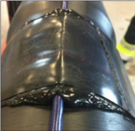
Figur 8.3 Ett krympsvep täcks över där kabeln är öppnad. Den värms upp så att den smälter och fastnar på ledningen [41].
