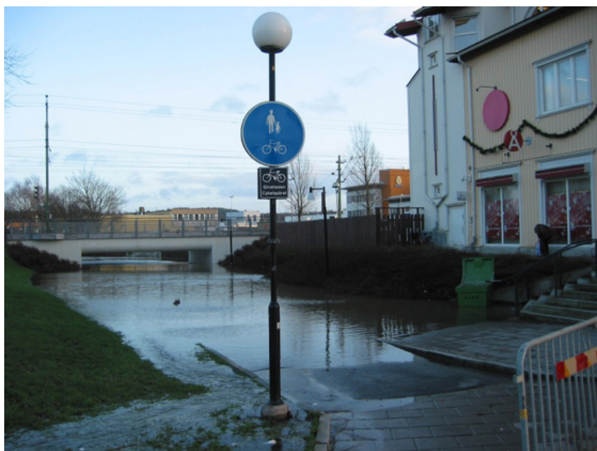
Figur 2-3 Ytledes stående vatten som pga. av otillräcklig regnvattenavledning trycker mot befintlig byggnadskonstruktion. (Sweco 2006)
