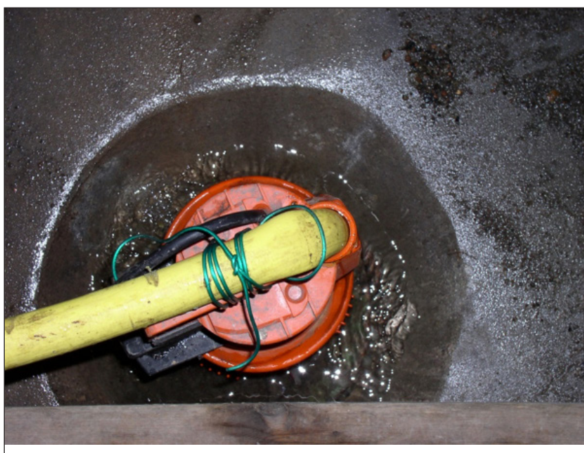
Figur 2.-1 Pumpning av upptryckande vatten ur invändig golvbrunn. (Sweco 2003)
