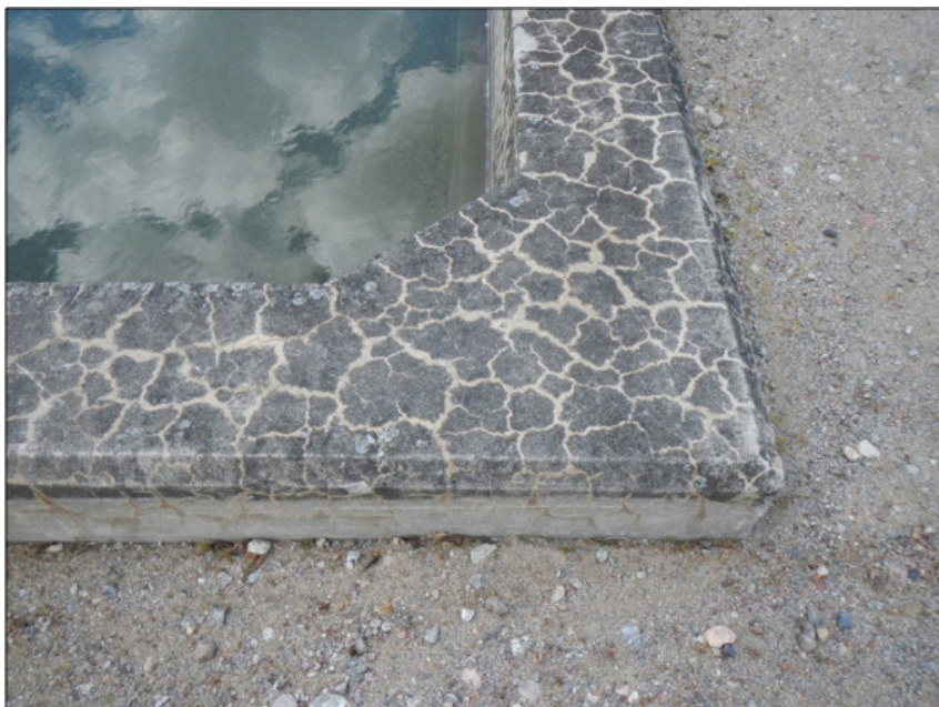
Figur 5-14 Krackelering i sargen runt ett långsamfilter troligen orsakad av milda frostangrepp samt termisk expansion.
