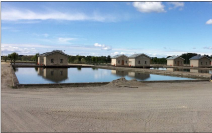
Figur 5-10 Vy över långsamfiltersbassänger i betong.
