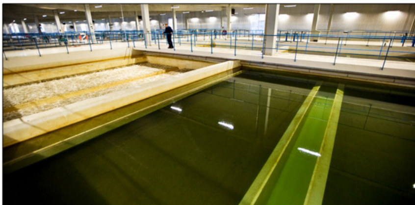
Figur 5-7 Bild på snabbfilterbassäng i ett vattenverk.
