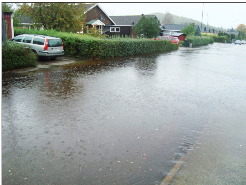
Figur 6-1 Exempel efter ett skyfall på en gata konstruerad i hängmatteform. Exempel från Oskarström, Halmstads kommun. Ortens sed kan i detta fall upplevas besvärlig för den källarfastighet som ligger till höger, precis utanför bilden. Foto: Mattias Salomonsson.
