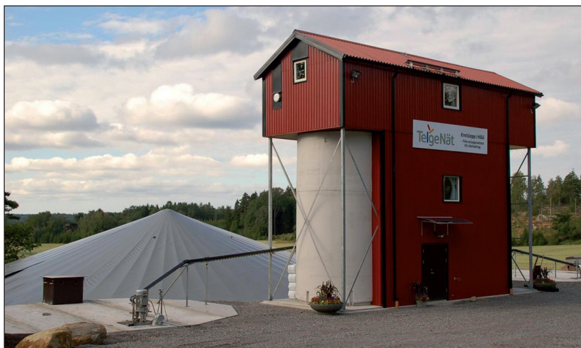
Figur 5-4 Hygieniseringsanläggningen i Hölö, Södertälje (Foto: Gösta Andersson)
