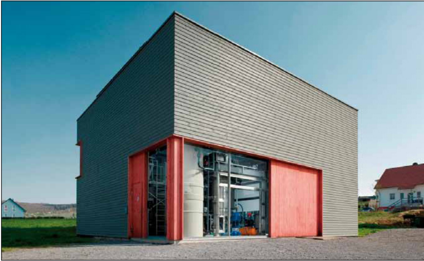
Figur 5-6 Foto över den lokala behandlingsanläggningen "Das Wasserhaus". Foto med tillstånd av Fraunhofer Institut, Stuttgart.
