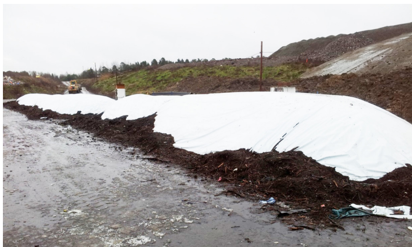
Figur 6-3 Ureabehandlade slamsträngar om 65 ton styck täckta med plansiloplast (foto: Annika Nordin)
