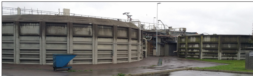
Figur 8-3 SBR vid Sjölanda avloppsreningsverk (till vänster) samt utjämningsbassäng efter SBR:en. På SBR:ens överkant är installerat ett snedställt skumplank. Foto: Ylva Eriksson.
