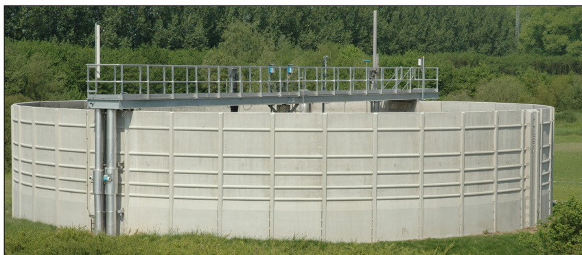
Figur 8-5 BABE-reaktor vid 's-Hertogenbosch avloppsreningsverk. Foto: Royal HaskoningDHV.
