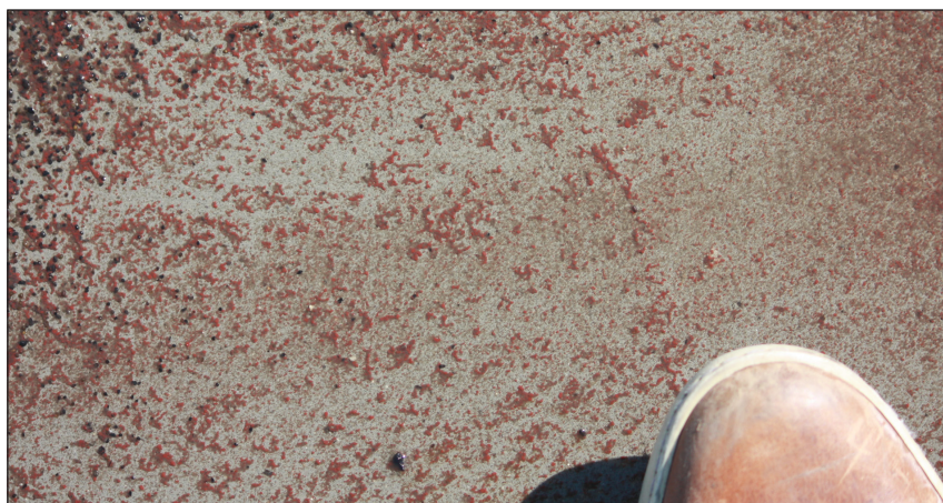
Figur 8-14 Vatten med innehåll av granuler från en av DEMON®-reaktorerna uthållt på ett betongbjälklag. På bilden syns även toppen av en herrsko.
