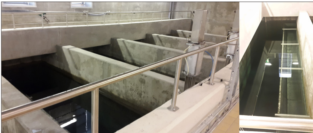
Figur 3.1 Filterbädd med aktivt kol. Bilden ha tagits i Bäcklösa vattenverk, Uppsala Kommun, av Nadine Belkouteb.
