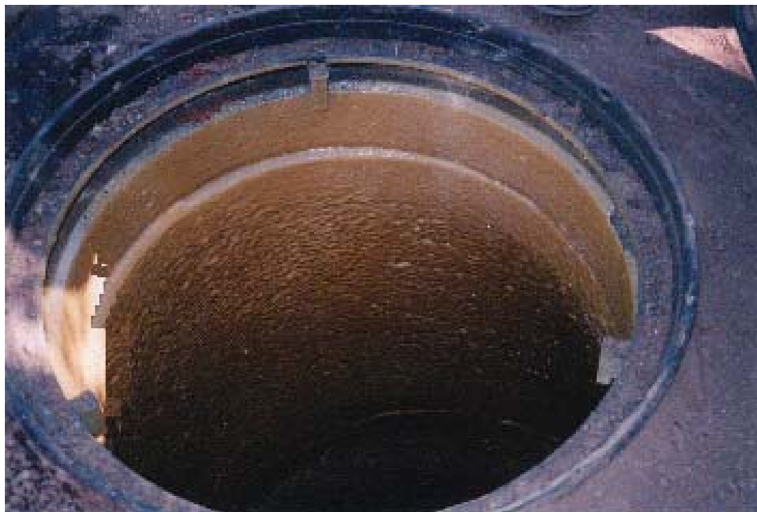
Bild 4.3.2. Brunn renoverad med beläggning (Spray-wall).
