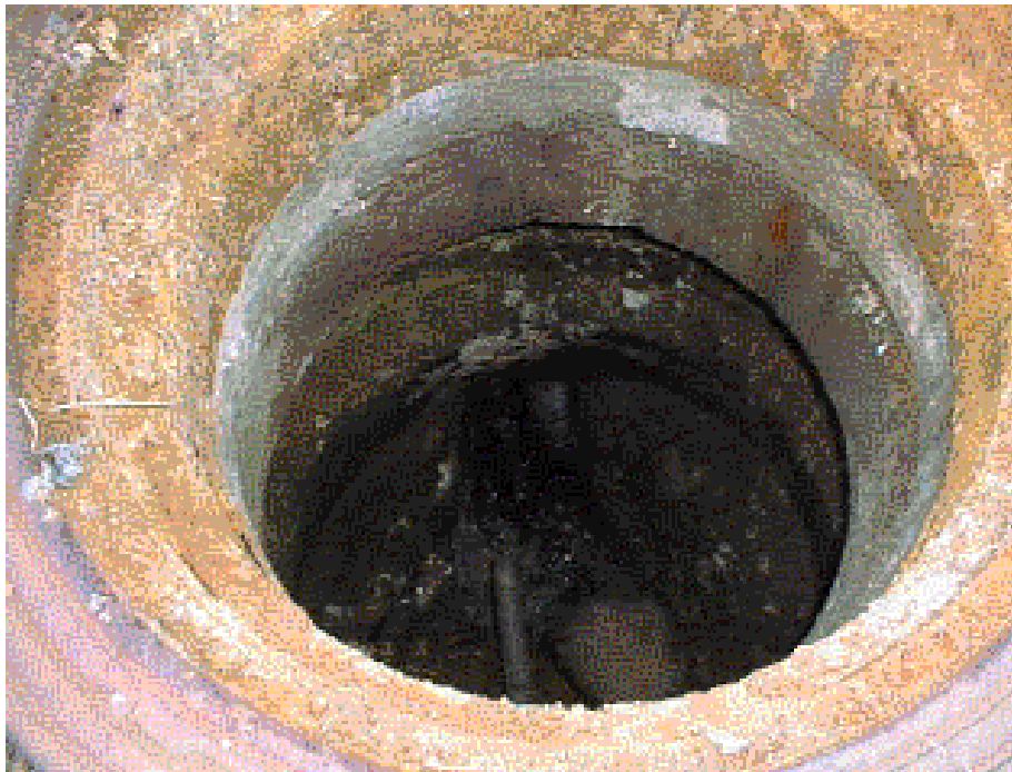
Bild 2.2.5. Förskjuten brunnssring.
