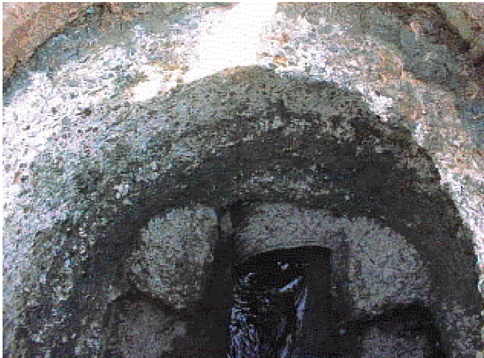
Bild 2.2.1. Kraftigt svavelväteangrepp där ballastmaterialet i betongen frilagts.
