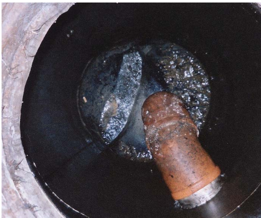
Bild 4.4.2. Renovering med formpassat rostfritt stål, inkommande ledning har förlängts med PVC-böj.
