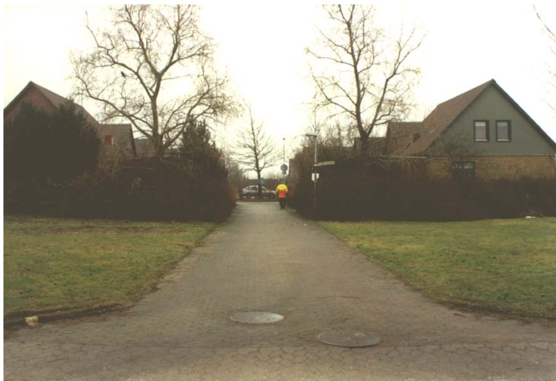
Fig. 10. Lergöksgatan 4-26 i Kastanjegårdsparken. De två poppelträden som flankerar vägen in till villaområdet har trängt in i avloppsledningarna som löper på 2,5–3 meters djup placerade i gångvägens mitt.
