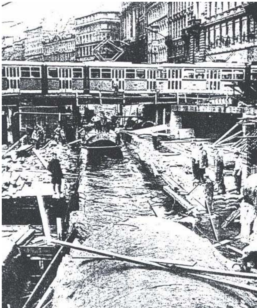
Figur 6. Byggnadsarbeten vid konstruktion av en tunnelbana som skulle korsas med en gammal spill- och dagvattenledning år 1965 (från Garami et al 1972).
