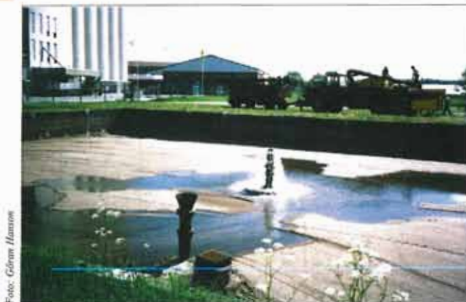
Bild 1.12. Bassänginfiltration vid Gorsingeholm, Strängnäs för produktion av industriellt kylvatten.
