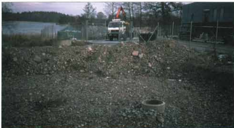
Bild 1.9. Grundvattenvärmesystem vid Brygga, Ekerö kommun. Varmt Mälärvatten har infiltrerats sommartid på bassängen i förgrunden för att höja grundvattentemperaturen. Uttag av grundvattenvärme görs med hjälp av värmepump. I bakgrunden ses brunnsöverbyggnaden (tältliknande) vid Mälarens strand, t h Ekebyhovs reningsverk.
