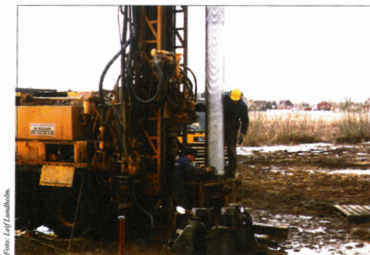
Bild 3.24. Utförande av formationsfilterbrunn vid Näs, Hallstahammar.
