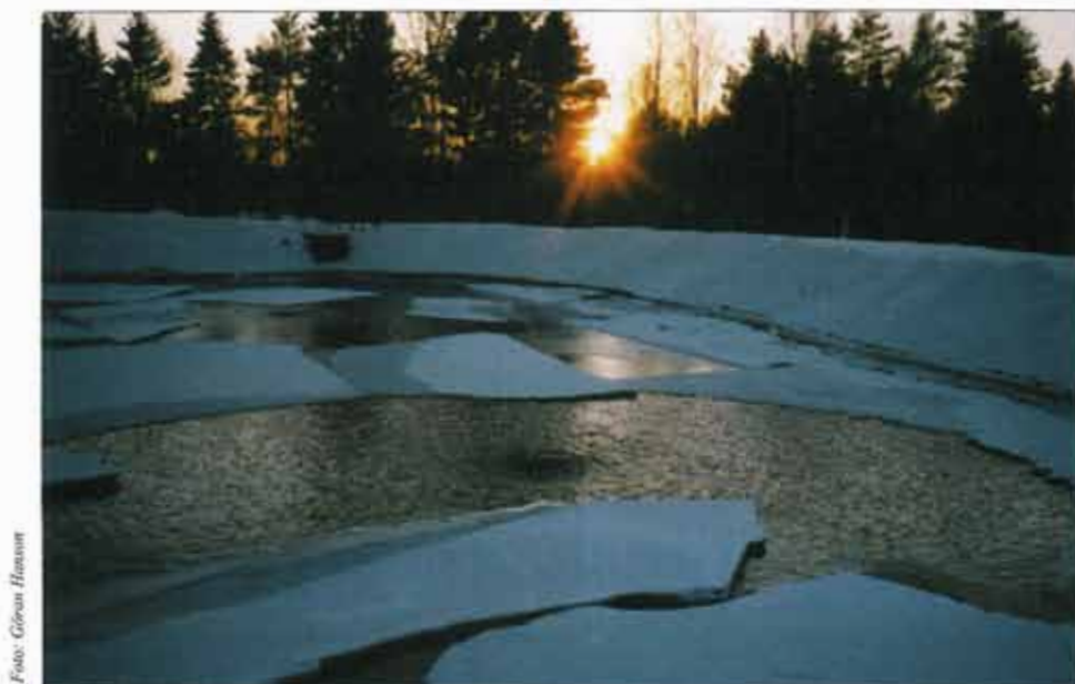
Bild 3.33. Vinterbild från Hyndevad, Eskilstuna. Strömningen kring utkastarna håller bassängen delvis isfri.
