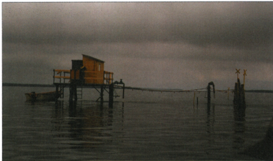
Bild 4.3. Tre undersökningsbrunnar vid Stallbrorgrund i Vänern för Mariestads vattenförsörjning. Provpumpningar utfördes 1997 i ett grundvattenmagasin under sjön, varvid ett inducerat läckage från Vänern uppstod.
