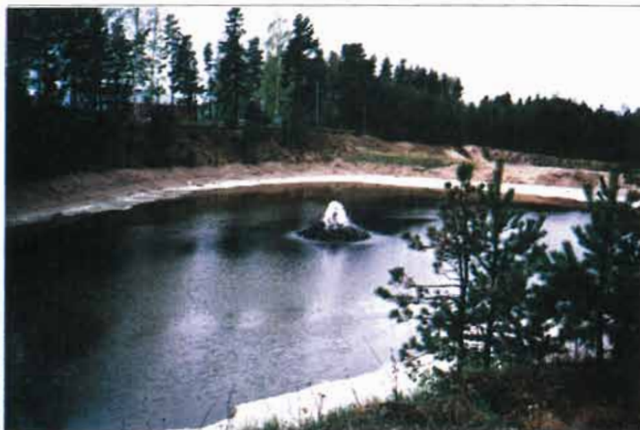
Bild 3.11 Infiltrationsbassäng i nedlagt grustag vid Kerstinboda, Katrineholm. Bassängen tillförs sand för att öka avståndet till grundvattenytan.
