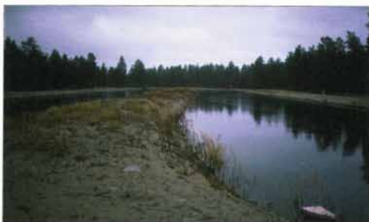
Bild 3.15 Infiltrationsdiken vid Gäddvik, Luleå.
