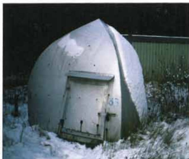
Bild 3.26. Olika typer av brunnsöverbyggnader. Överst t v Långholmen, Kristinehamn. En praktisk konstruktion med utfällbara snedställda luckor som gör pumpinstallationen lättåtkomlig. Överst t h Sandudden, Ekerö - en prefab-modell i aluminium. Hela brunnsöverbyggnaden kan lyftas bort i en ögla i toppen. Nederst t v Högåsen, Nyköping. Brunnsöverbyggnaden kallas "Biskopsmössan". Nederst t h Gällerråsen, Karlskoga. Brunnsöverbyggnad i betong - som ett konstverk. I bild Göran Spåre t v och rapportförfattaren t h.
