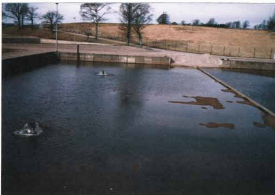
Bild 3.18 Avdelad bassäng vilket underlättar rensning vid Kärreberg, Falkenberg.
