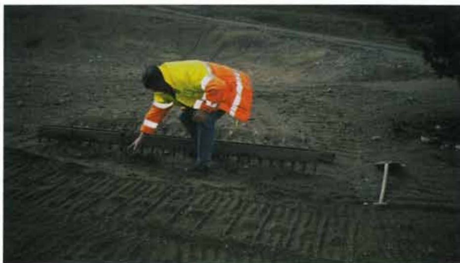
Bild 3.37. Uppluckring av filterbädd med "harvningsutrustning" vid Fjärås, Kungsbacka.
