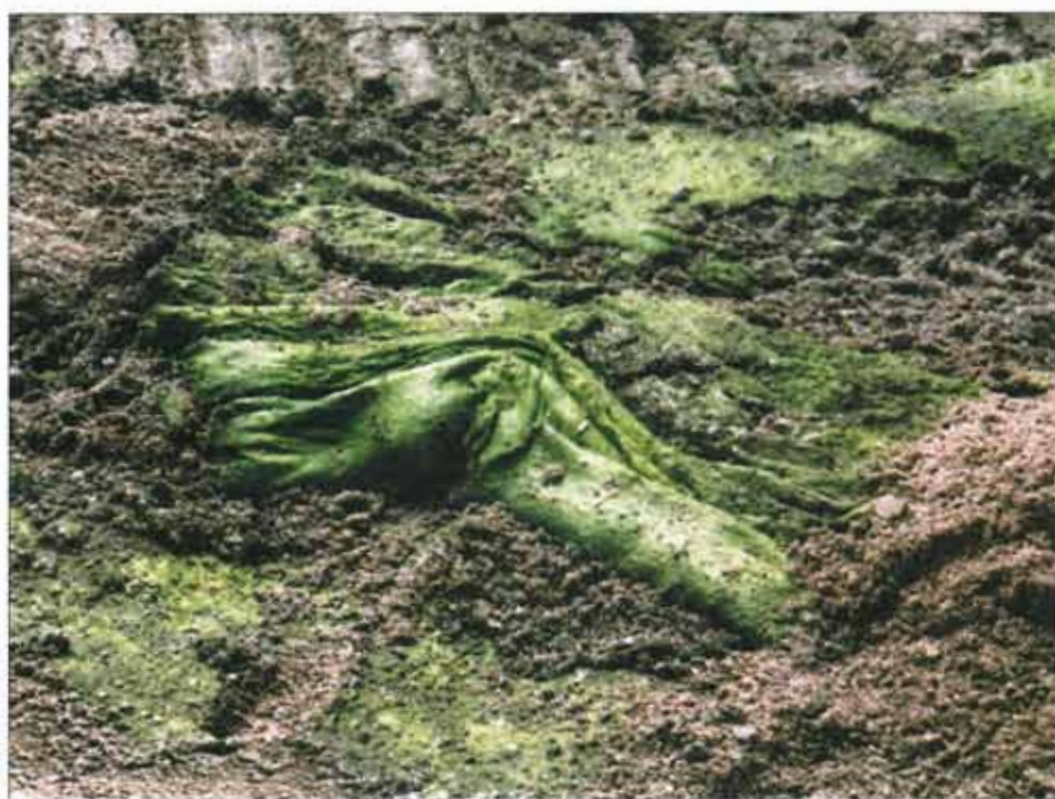
Bild 3.35 Filterhud (algmatta) i en infiltrationsbassäng vid Källtorp, Södertälje.
