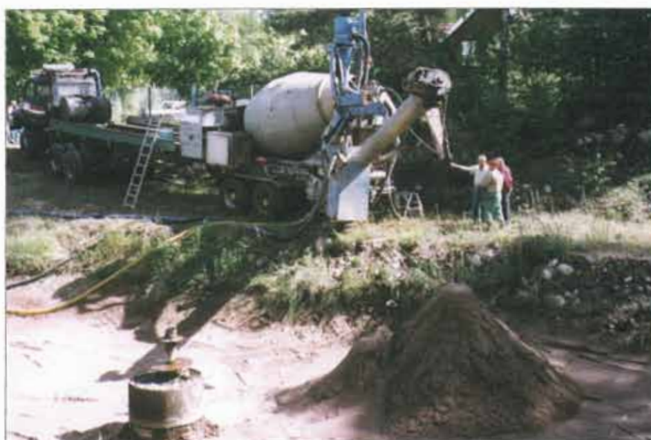
Bild 3.40. Sandtvätt som lämpar sig för djuptvätt. Fotografiet taget vid Skantzen, Hallstahammar.
