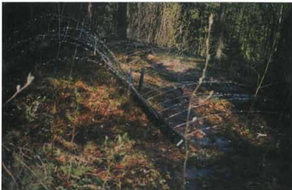
Bild 4.15. Detalj av sprinklerinfiltration vid Tavastehus, Finland.
