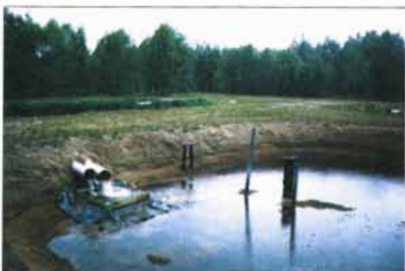
Bild 3.14 Bräddning mellan infiltrationsbassänger vid Djurtorp, Ronneby.
