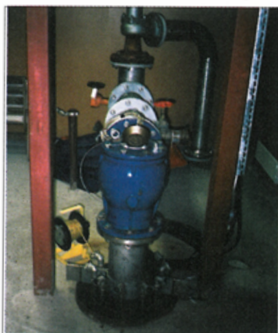
Bild 4.7. Permanent rensningsutrustning vid Långholmen, Kristinehamn. Se bild 4.6 angående utformning och rensningsförfarande.
