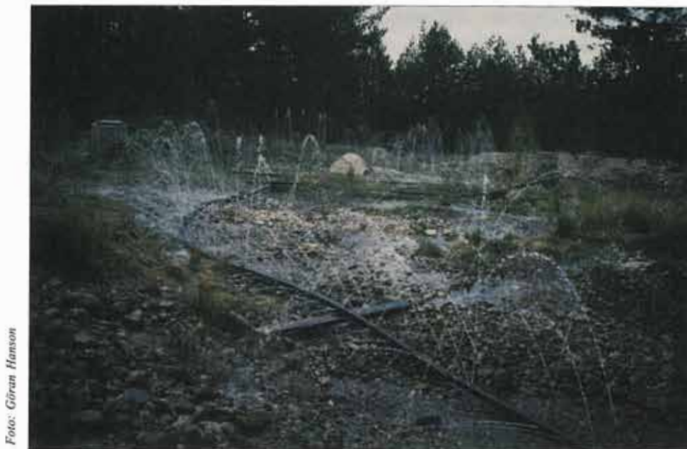
Bild 4.13. Sprinklerinfiltration vid Sannäs i Borgå, Finland.
