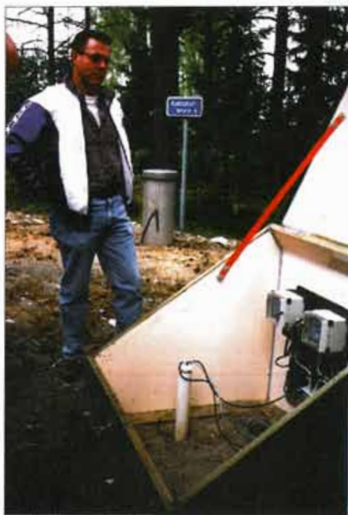
Bild 6.6. Kerstinboda, Katrineholm. I bakgrunden ses en "katastrofbrunn"; i förgrunden ett observationsrör för kontroll av vattenkvalitet som försetts med larmanordning.
