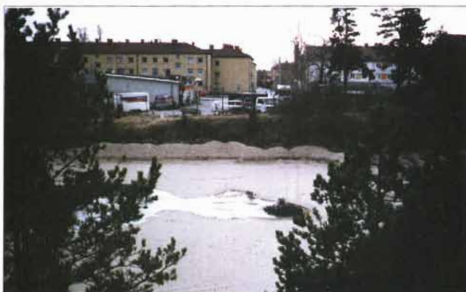
Bild 6.5 Infiltrationsbassäng vid Kerstinboda, Katrineholm med en bensinstation i bakgrunden som försetts med speciella skyddsanordningar, bl a invallning av tankar samt olika larmsystem i händelse av förorenings-spridning.
