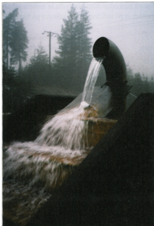
Bild 5.10 Luftningstrappa vid vattenverket i Sandköping, Kristinehamn
