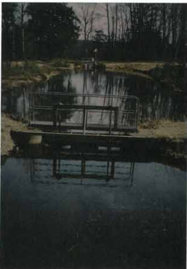
Bild 5.5 Öppna flocknings- och sedimentationsbassänger vid Getasjökvam, Emmaboda.
