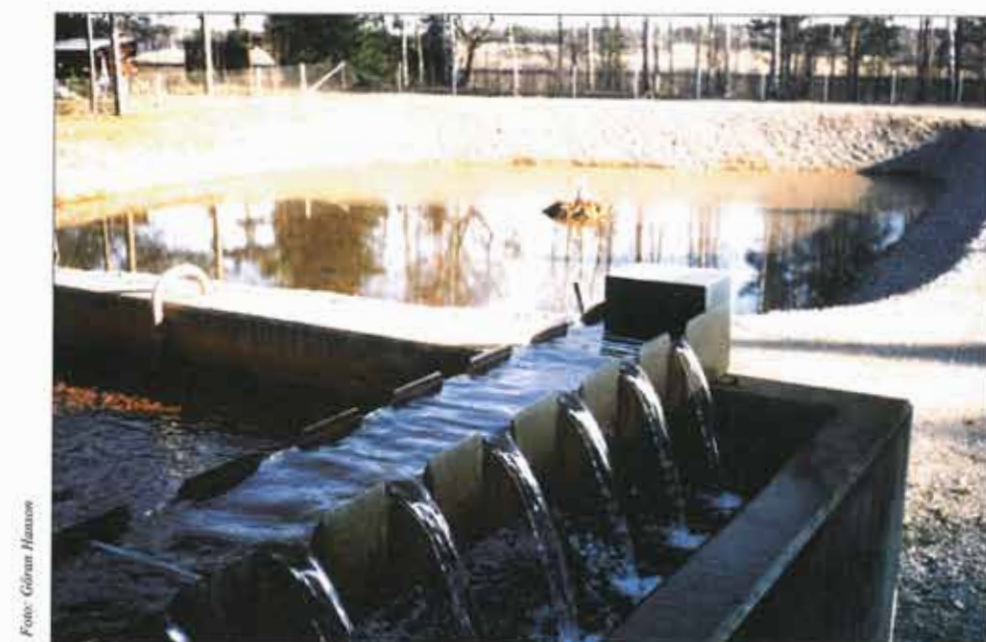
Bild 5.9 Förfilter av makadam (i förgrunden) vid återinfiltrationsanläggningen Visbohammar, Gnesta. I bakgrunden ses infiltrationsbassängen.
