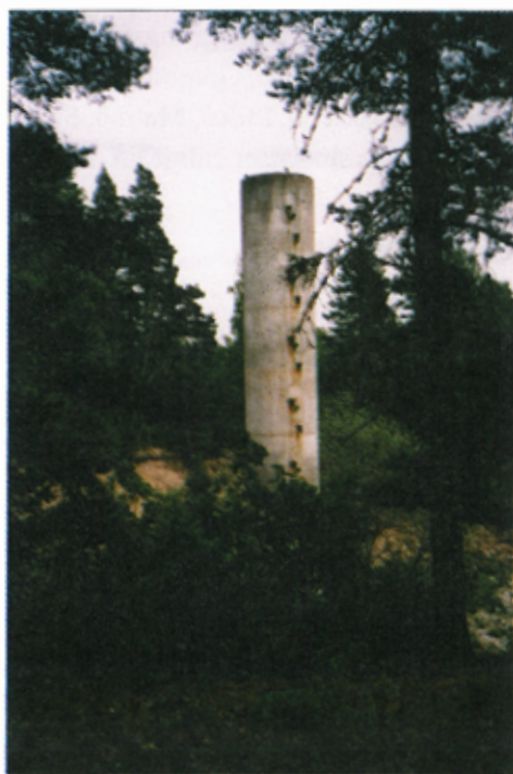
Bild 7.1 Undersökningstorn vid Hyndevadsverket i Eskilstuna. Tornet användes under 1950-talet för studier av infiltrationsprocesser.
