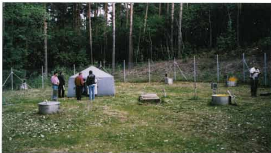
Bild 5.12. Vyredox II-anläggning vid Näs, Hallstahammar. Bilden visar uttagsbrunnen (där flertalet personerna står) och i ring runt denna ett antal syresättningsbrunnar. Ive Blomberg (vid brunnsöverbyggnaden) demonstrerar anläggningen för en SIDA-grupp från Uruguay. Th rapportförfattaren.
