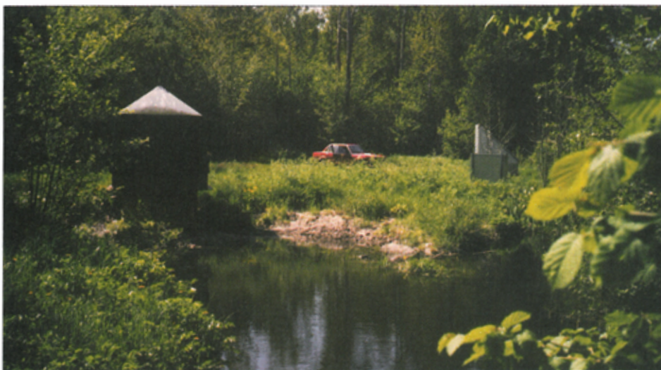
Bild 5.1 Råvattenintag i Lindby kanal för vattenverket i Köpingsvik på norra Öland som bl a försörjer Borgholm.
