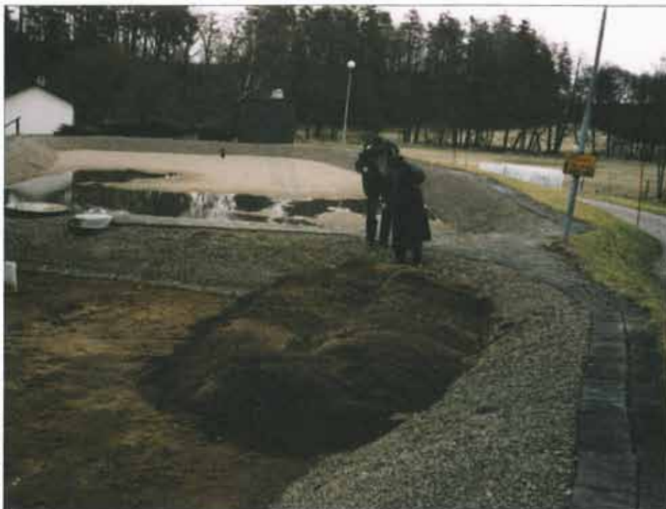
Bild 5.3. Förfilter för att avskiljning av järn, mangan och humus vid Jonstorp, Falkenberg. Högen med förorenad filtersand ska forslas bort och ny filtersand läggs ut i bassängen. Högen inspekteras här av Jonas Hedström, Göteborgs Universitet, som studerat igensättningar vid infiltrationsanläggningar i Falkenberg (se kap 7), och Christer Gedda, KM, Halmstad.
