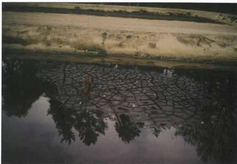
Bild 5.7. Bassänger som satts igen av tvättvattnet efter kontaktfiltrering vid vattenverket i Maglaröd, Osby. Bilden togs i maj -97 när anläggningen var ny. Numera har problemet lösts genom installation av förtjockare som gör tvättvattnet mindre slambemängt (slammet körs i stället till deponi).
