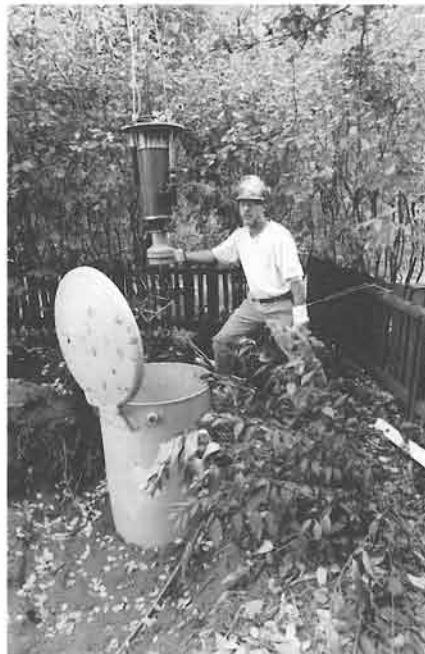
Bild 2. Montage av pumpenhet typ LPS.
