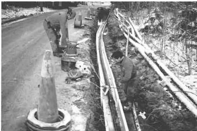
Bild 8. Svetsning av rör med svetsmuff.
