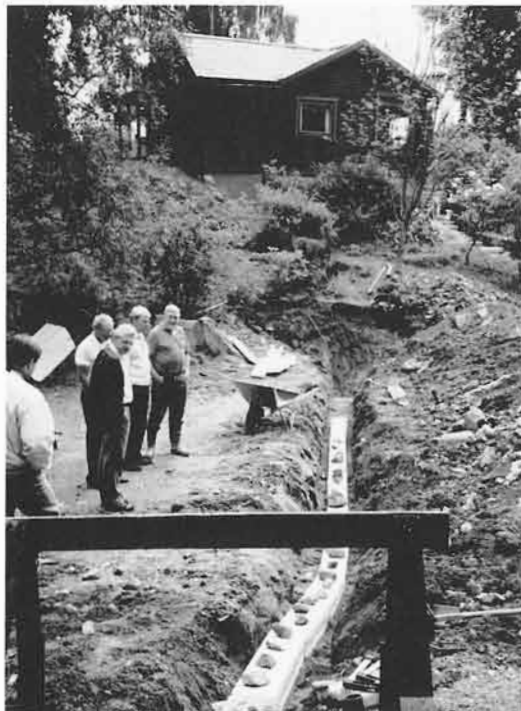
Bild 10. Grunt förlagda servisledningar förlagda i isolerlåda. Pumpstationen är ännu inte satt.
