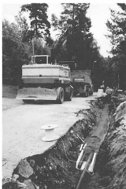
Bild 5. Läggnings av vattenledning och tryckavloppsledning ingående i ett PSS-system. Ledningarna läggs på ett djup av cirka 0,7–0,8 m i en sandfylld isolerlåda med värmekabel.
