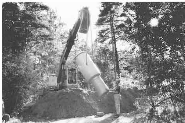
Bild 1. Sättning av pumpstation typ LPS tillverkad av glasfiberarmerad plast, äldre modell. Nuvarande modeller utförs i polyeten.
