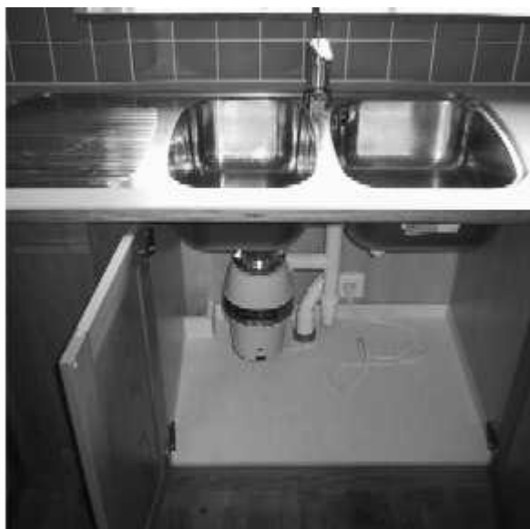
Figur 1. Köksavfallskvarn monterad under diskbänken. (Foto: Christopher Gruvberger, 2001).
