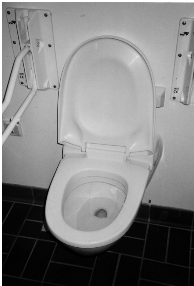
Figur 4. Vakuumtoalett i Tegelvikens skola. Spolknappen sitter strax bakom locket. (Foto: Birgitta Rydhagen, 2001).
