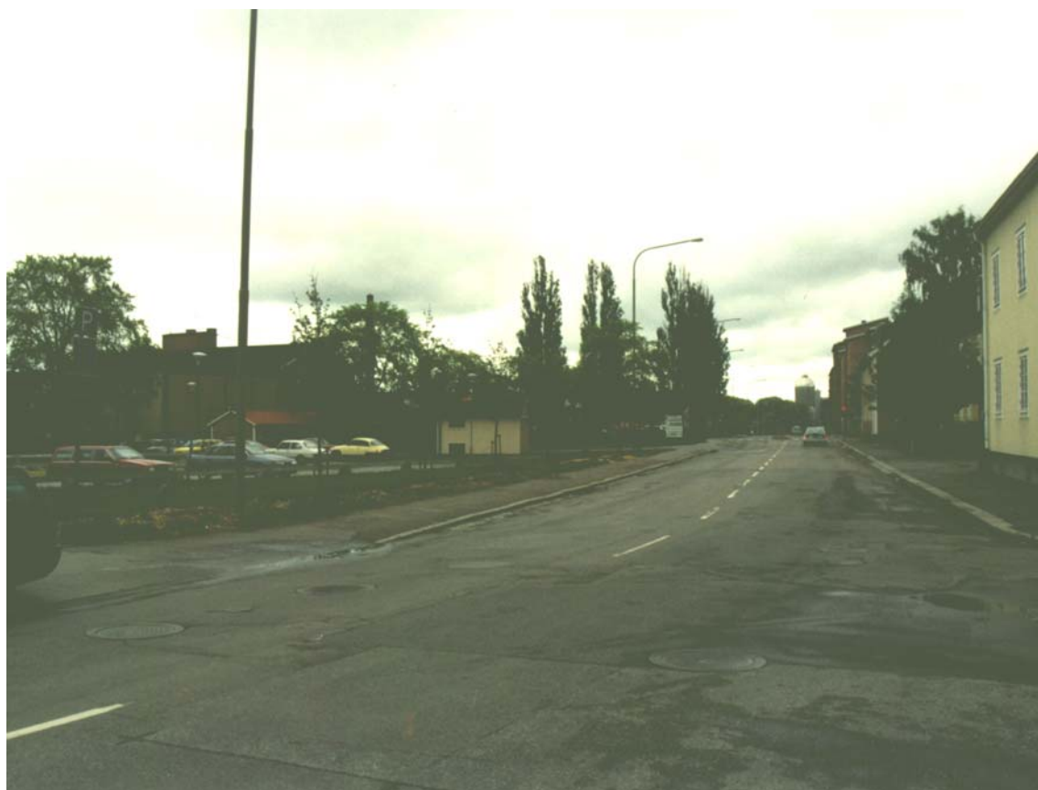
Fig. 20. Sveagatan i Linköping med en nyplanterad rad av pelarekar. Avloppsledningar finns placerade i gatans mitt på 3-4 meters djup. Några gamla pyramidpopplar, som tidigare även fanns planterade här, skymtar längre ned på gatan. De kvarlämnade pyramidpopplarna utgjorde ej något problem för avloppsledningarna.
