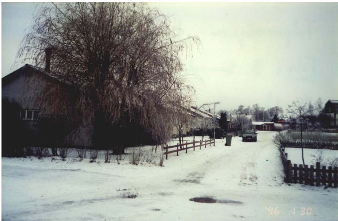
Fig. 19. Tulpanvägen i Linköping. Avloppsledningar ligger här placerade i vägens mitt. Pilens rötter hade i detta fallet passerat vägens överbyggnad och trängt in i servisen på motsatt sida om vägen.
