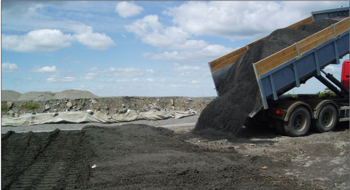
Figur 4-10. Utläggning av slam/aska-blandning vid SRV Återvinning, juni 2005.
