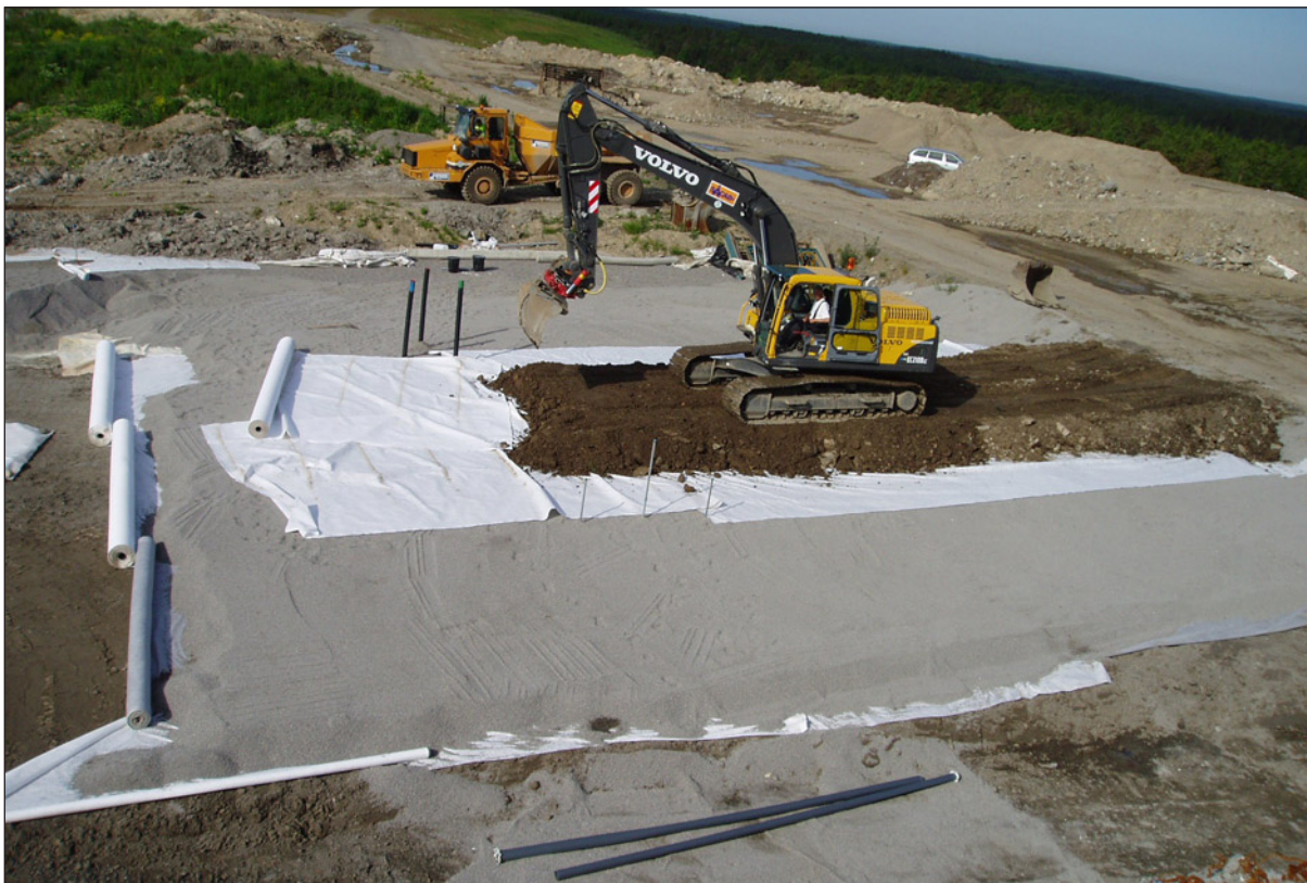
Figur 4-12. Utläggning av skyddsskikt på SRVs provyta.
