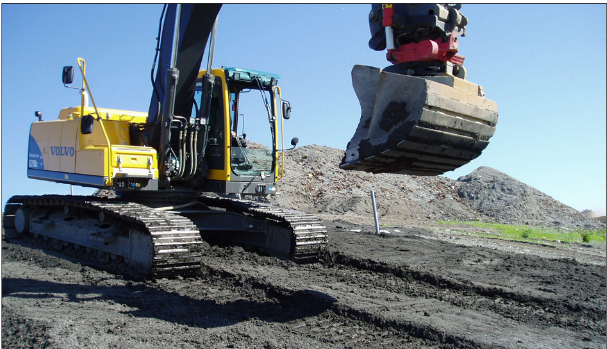
Figur 4-11. Packning av tätskiktet i slänt på SRV Återvinning.
