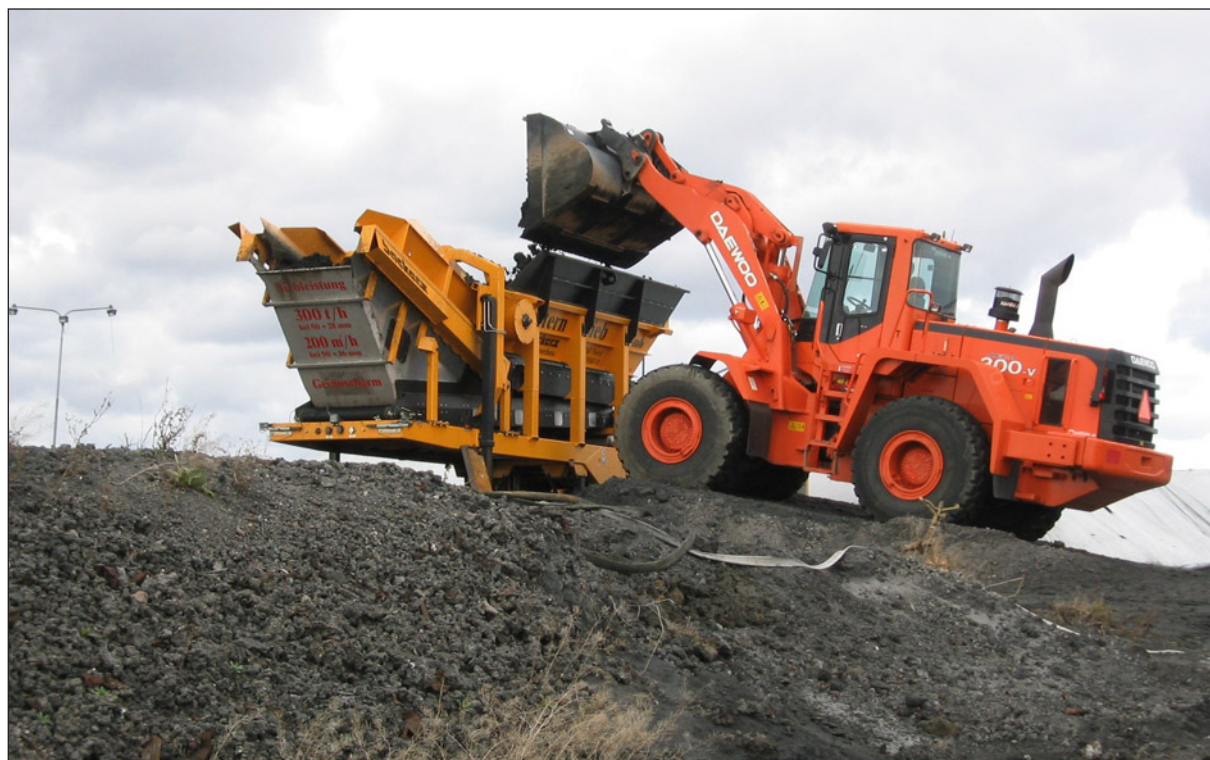
Figur 4-2. Illastning av slam till stjärnsikten, Tekniska Verken, september 2004.
