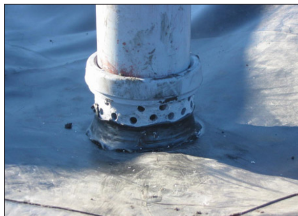
Figur A-4. Exempel på utlopp för lysimeter. Stös svetsad mot geomembranet och med utloppsledningen ansluten.
