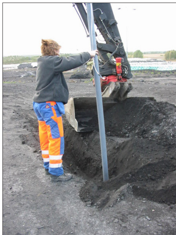
Figur A-7. Installation av skyddsrör för gasprob.
